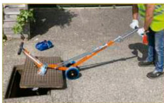
Uso 2: levantamiento con palanca plegable
